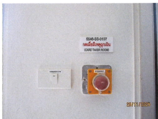
ภาพที่ 2-7 อุปกรณ์แจ้งเตือนและป้องกันอัคคีภัยบริเวณสถานีควบคุมก๊าซ
